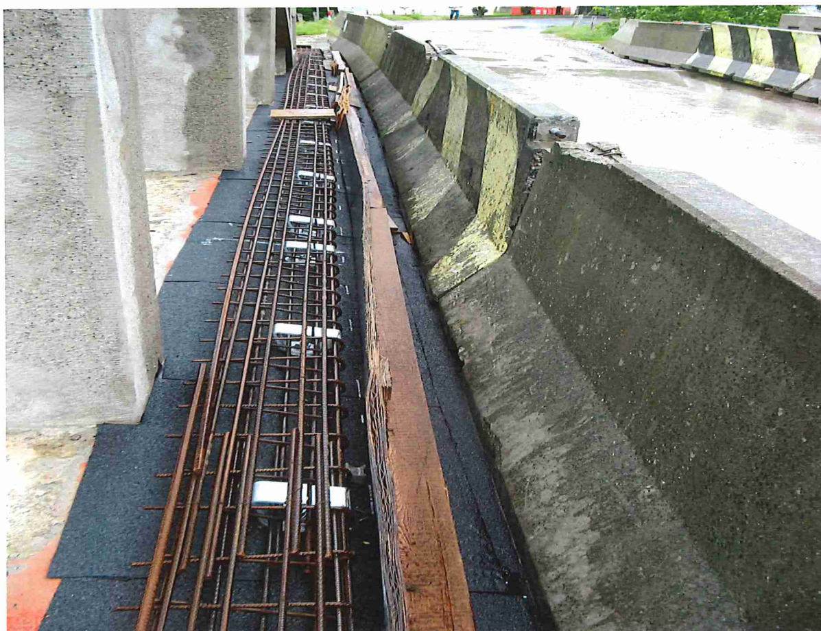
Obr. 5 Výztuž římsy na mostě
