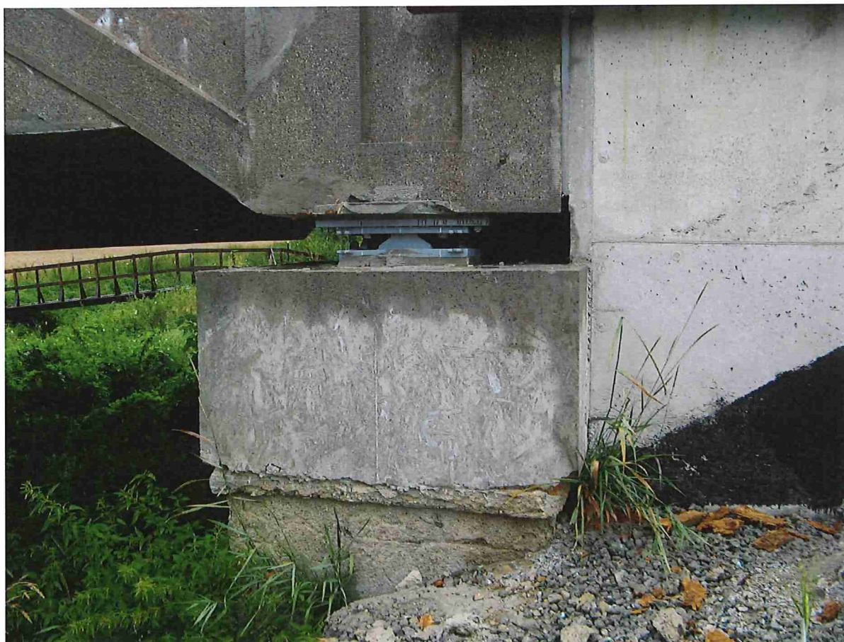
Obr. 6 Detail v oblasti uložení – opěra Lubnice
