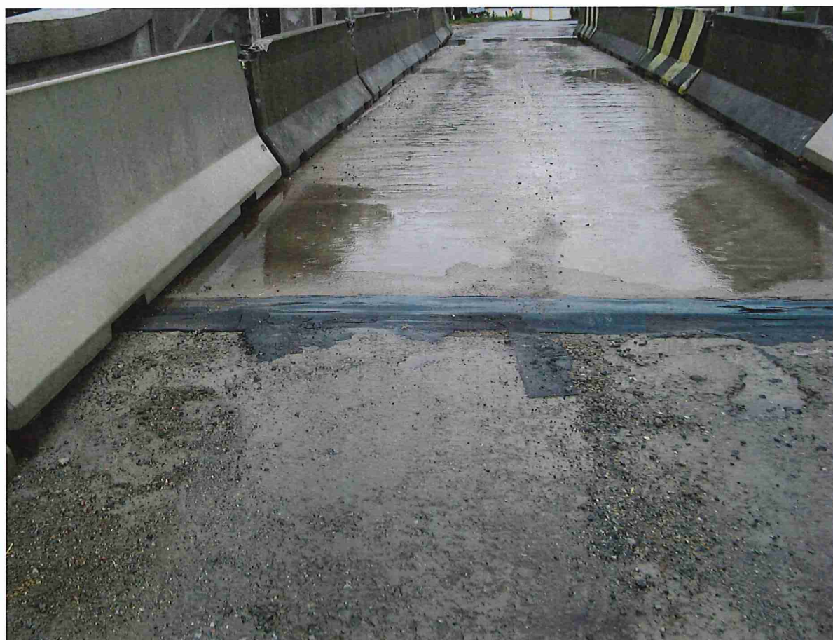
Obr. 2 Provedení desky mostovky a dilatace
