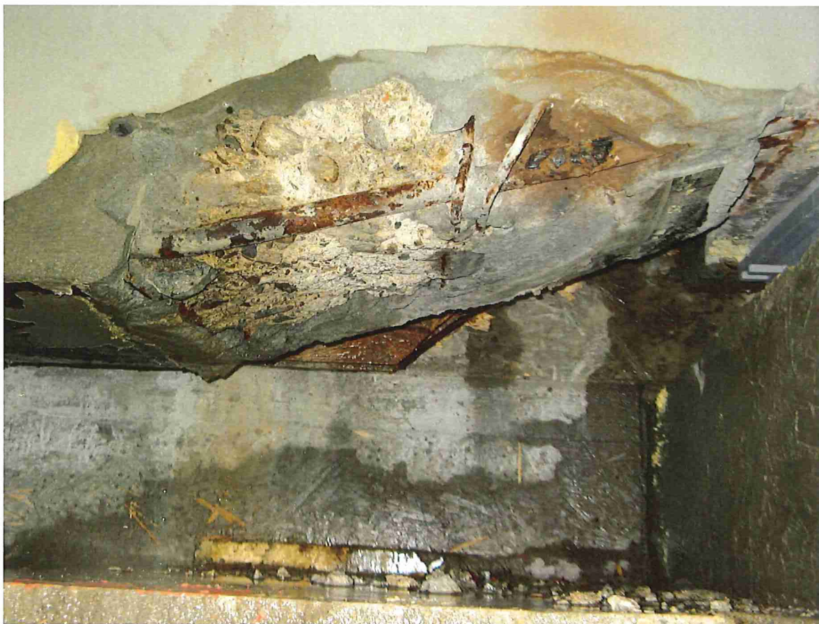
Obr. 9 Poškození podporového příčnicku včetně výztuže, nevyhovující svarový spoj
