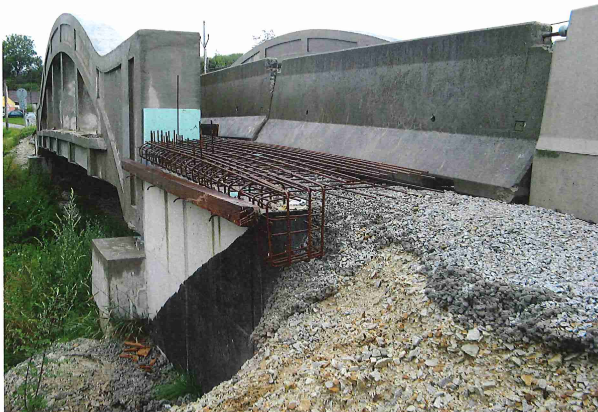
Obr. 3 Provedení křídel, obsypů, výztuž říms
