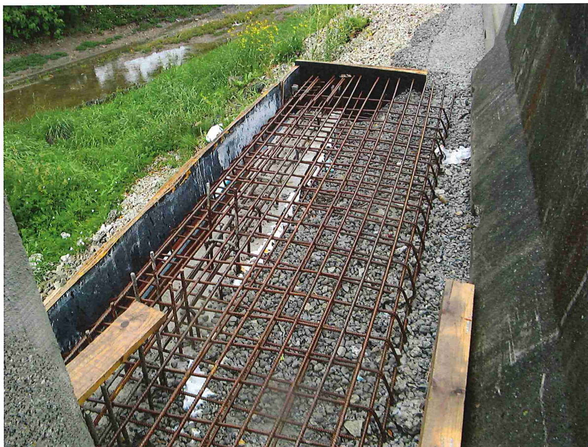
Obr. 4 Výztuž říms na křídle
